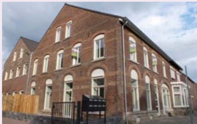
8 appartementen in monumentaal pand aan de Ambyerstraat - Maastricht.
